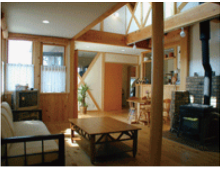
柱、スジカ、床板、根太にまでヒノキの無垢材を使用。壁は漆喰の塗り壁。木と漆喰のさまざまな効能でつくるぎ空間を演出。
